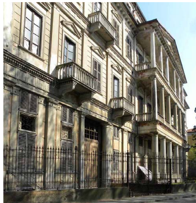
Novara, Casa De Santi-Bossi: la facciata.
